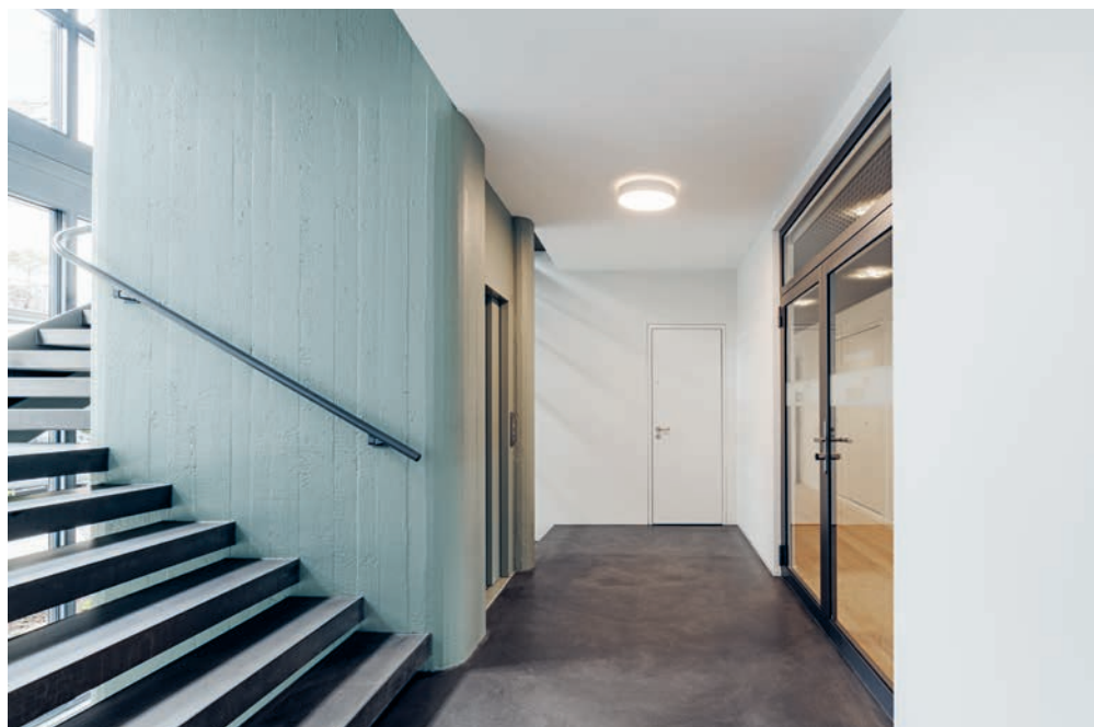
Das bestehende Treppenhaus wurde beibehalten und erschliesst als statischer Kern das gesamte Gebäude.
