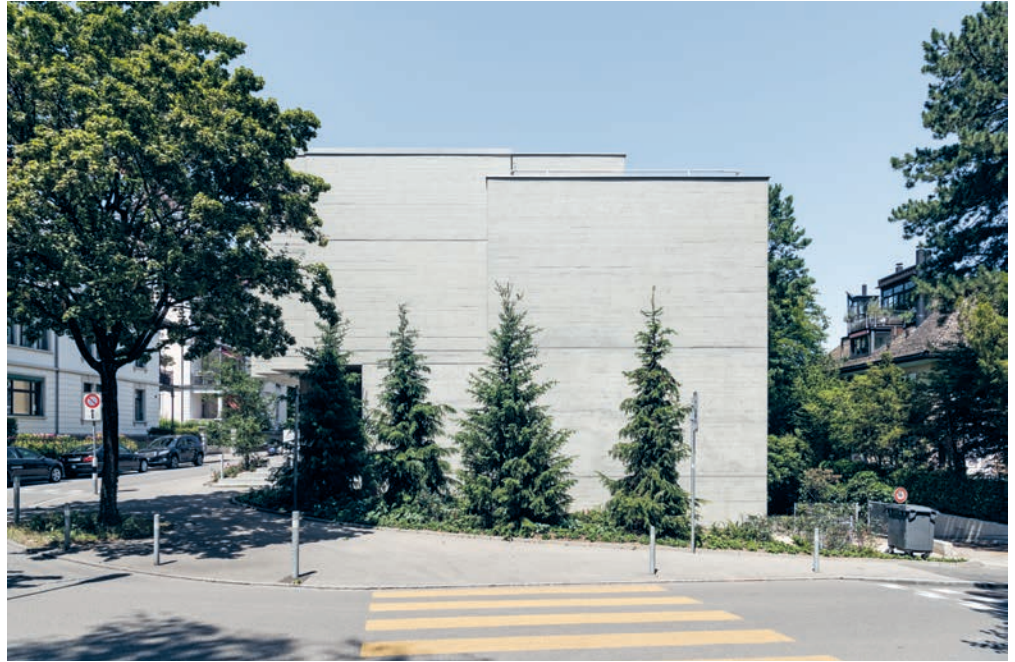
Im Rahmen der Umnutzung wurde die Sichtbetonfassade gründlich untersucht, rostende Armierungen freigelegt und die alten Dilatationsfugen ersetzt.
